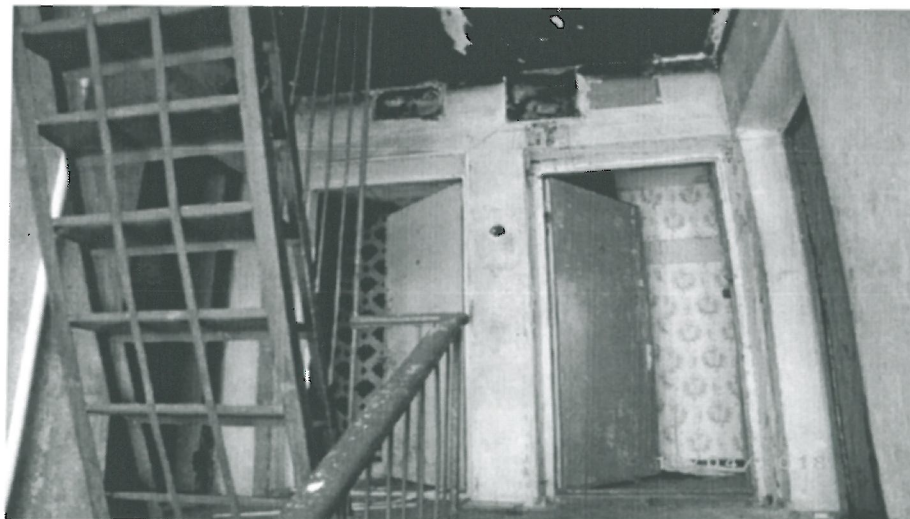
Foto 8. 4 korruse trepimademe seisukord peale põlengut
